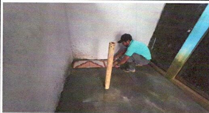
FOTO 3: Mejoramiento de piso de los sanitarios, instalando piso cerámico
