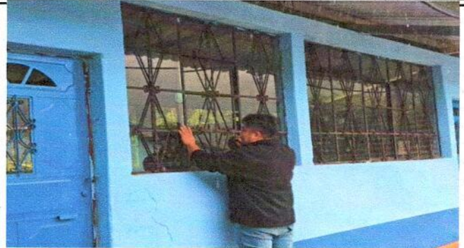
FOTO 2: Colocación de vidrios a Ventanas del aula de preprimaria
