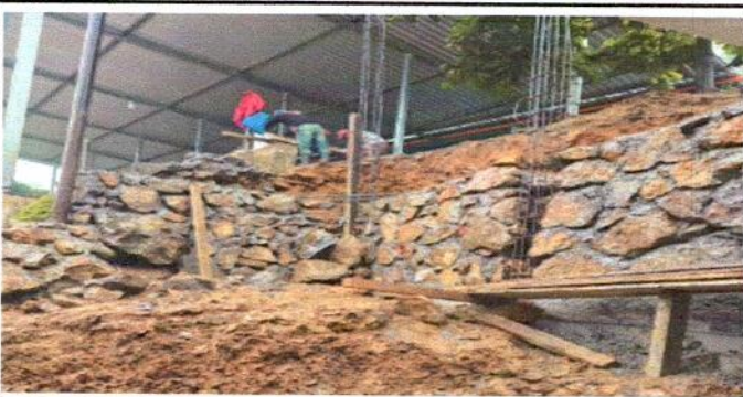
FOTO 5: Mejoramiento de muro perimetral con gradas
