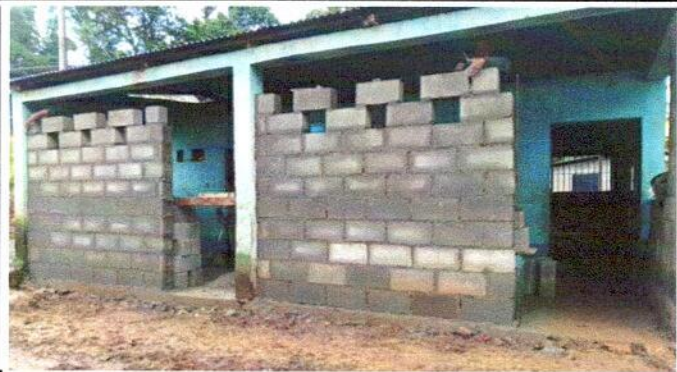
FOTO 7: Reparación o sustitución de área de cocina. Y aplicación de pintura en cocina y aulas
