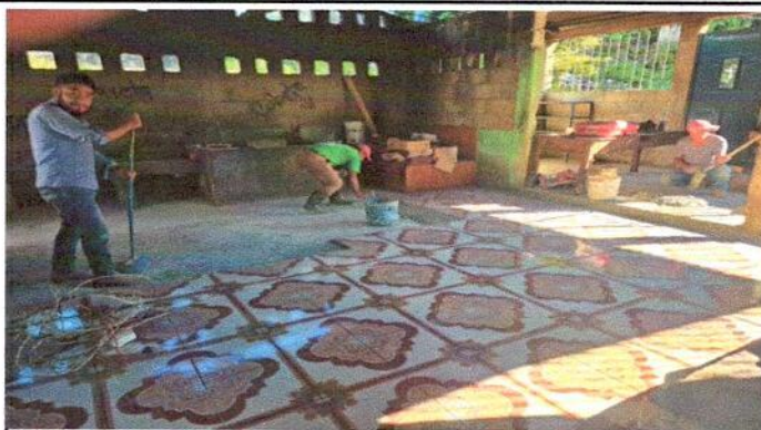
FOTO 8: Reparación o sustitución de área de cocina
