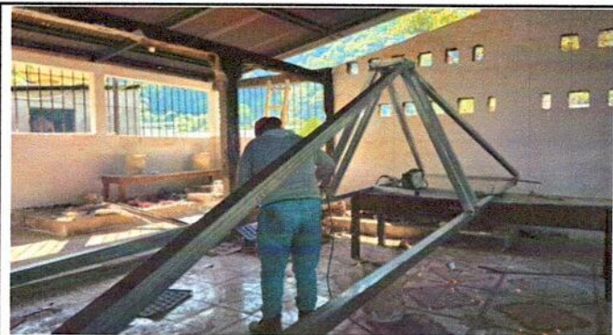
FOTO 9: Reparación o sustitución de área de cocina (Plancha)
